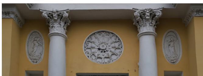
Ил. 23. Танцовщицы в овальных медальонах. Барельефы на фасаде флигеля городской усадьбы Е. Колотилова. Ярославль, Ушинского, 16. Фото С. М. Царёвой.
