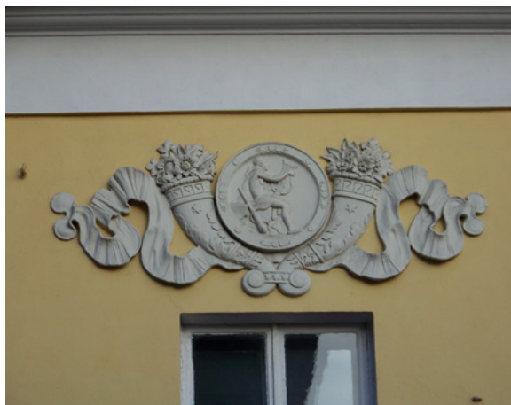
Ил. 33. Геркулес Мусагет. Барельеф на фасаде дома В. А. Глебовой. Москва, Колымажный переулок, 4. Фото С. М. Царёвой.
