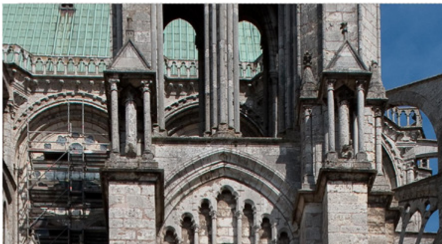
Ил. 6. Шартрский собор. Табернакли, увенчивающие аркбутанно-контрфорсные конструкции, примыкающие к южной стене хора: чередование расположенных внутри них граненых и круглых в сечении опор. После 1194 года.
