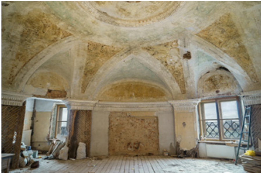
Ил. 5. Верхнее помещение после проведения укрепления и расчисток. Общий вид. 2015.
