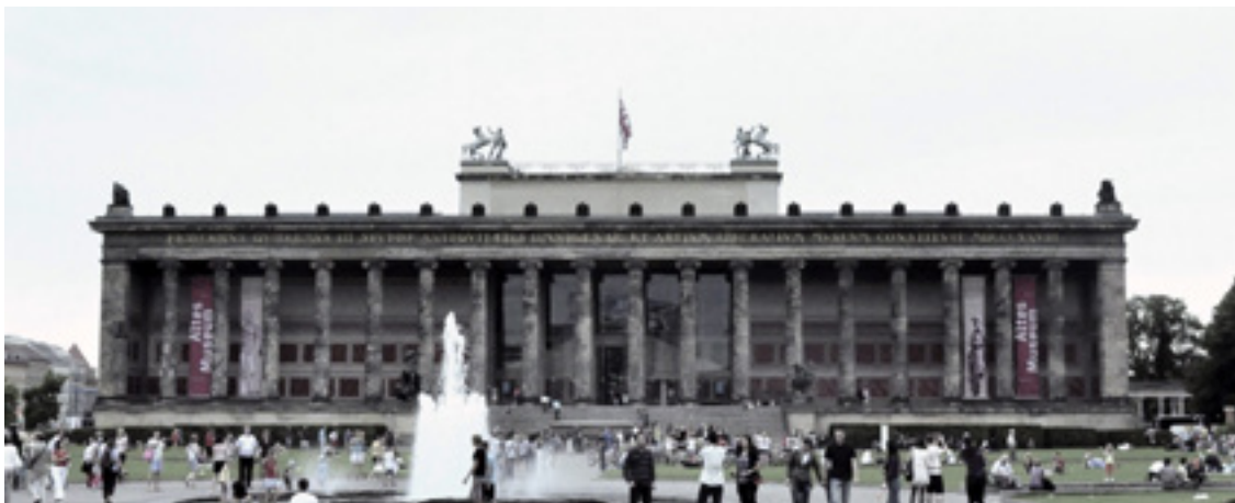
Ил. 14. Карл Фридрих Шинкель. Старый музей. 1823–1830. «Музейный остров», Берлин. Фото К. Л. Лукичевой.
