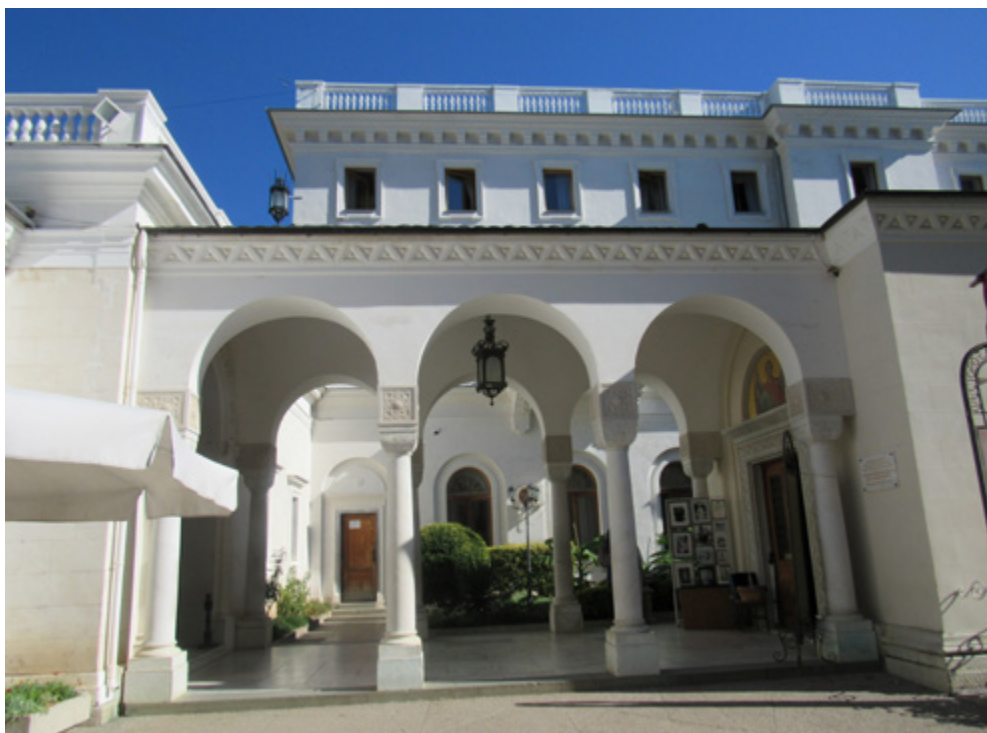
Ил. 15. Аркада галереи входа в храм. Ливадия. Фото И. Н. Слюньковой. 2018.
