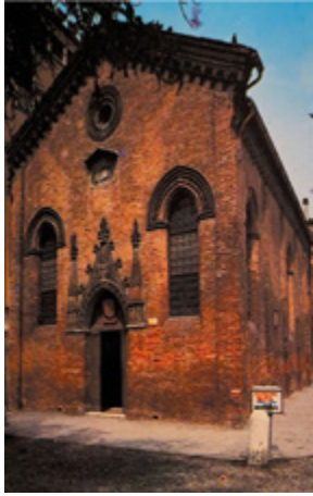
Ил. 23. Церковь Сан Джулиано. Разрушена в 1385, восстановлена в 1405 году. Феррара.
